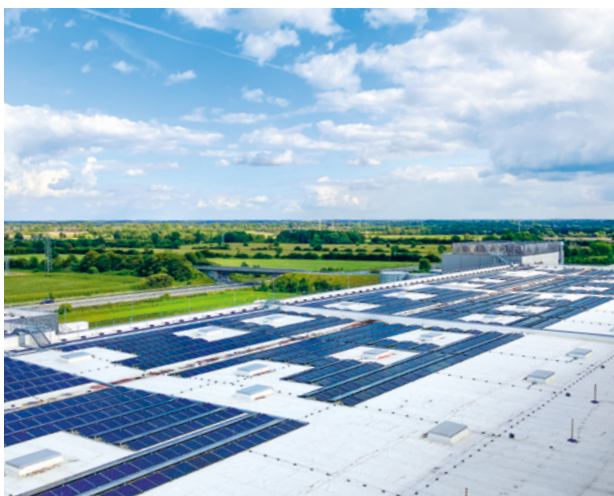
Die PV-Anlage am Lagerstandort Neumünster-Eichhof dient u. a. zur Versorgung des Tiefkühlagers.
