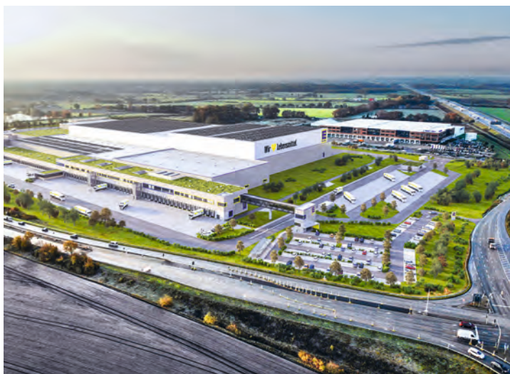
Auf dem rund 25 Hektar großen Areal im Gewerbepark Eichhof in Neumünster gehen die Baumaßnahmen für das neue Frischdienstlager voran.
