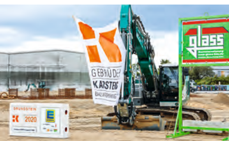
Start des Erweiterungsbaus im Logistikzentrum Malchow
