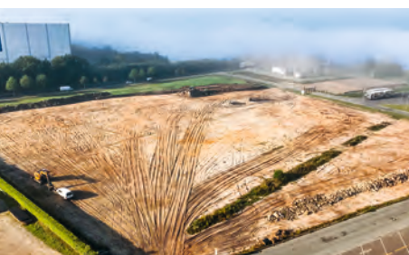
Zum Jahresanfang begannen die Bauarbeiten für den Neubau des Tiefkühlagers in Zarrentin.
