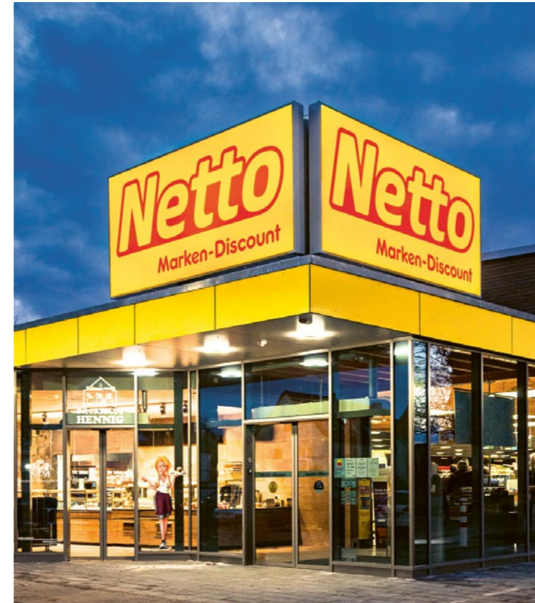
Auch bei der technischen Gebäudeausstattung kommen nachhaltigere Konzepte wie Holzbauweise, Betonkernaktivierung sowie eine Fotovoltaik-Anlage auf dem Dach zum Einsatz.
